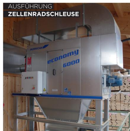
Zur drucklosen Befüllung des Späne- und Hackschnitzzellagers. Übergabe an eine pneumatische Förderanlage.
